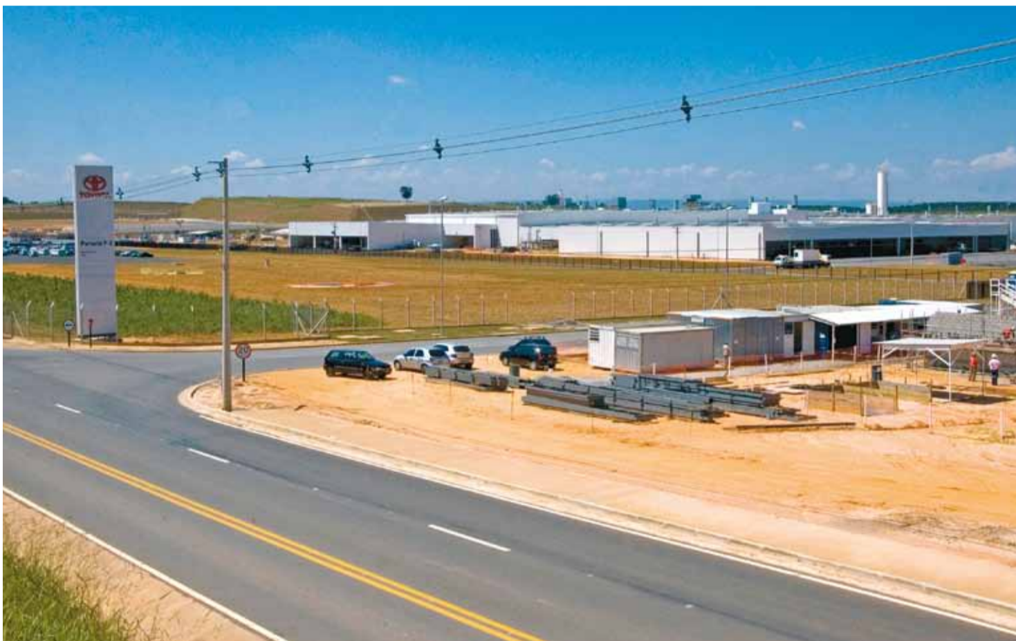
Construção da montadora, às margens da rodovia Castello Branco (km 92), está com os principais pavilhões já levantados e ritmo das obras é intenso
